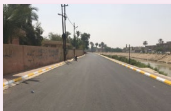
伊拉克穆沙拉道路改造前後
